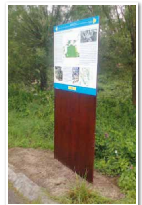
Stahltafel S = 20 mm, blank, mit Schild aus Signicolor
