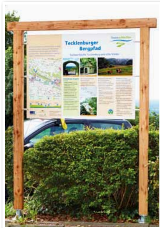
(Bildquelle Tecklenburger Landtourismus) Rahmen aus Douglasie/KDI Montage mit Gotischen Träger und Wurzelpfahl
