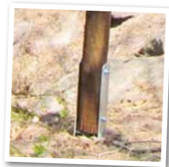
Rundholzpfosten, Montage mit H-Pfostenträger
