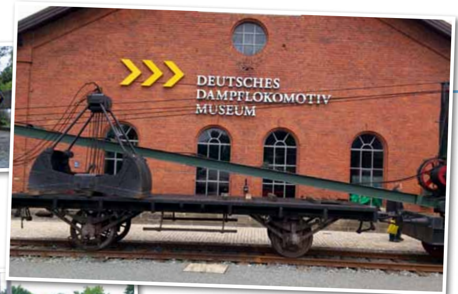
Fassadenbeschriftung Ausleuchtung mit LED
