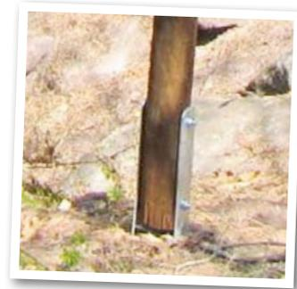
Rundholzpfosten, Montage mit H-Pfostenträger
